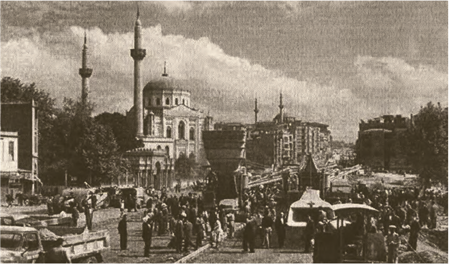
3- Aksaray'da yol açma çalışmaları
