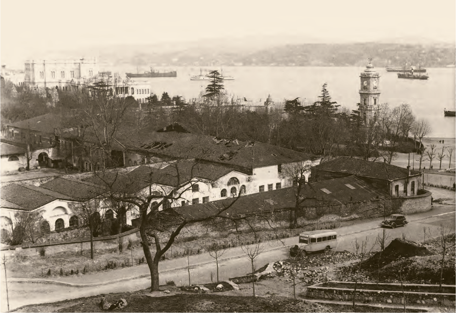
12- Dolmabahçe Sarayı'nın has ahırları ve Tiyatro-yı Şâhâne, Milli Şef devrinde yıkılarak yerine İnönü Stadyumu yaptırılmıştı. Yukarıda söz konusu has ahırların nadir fotoğraflarından biri görülüyor
