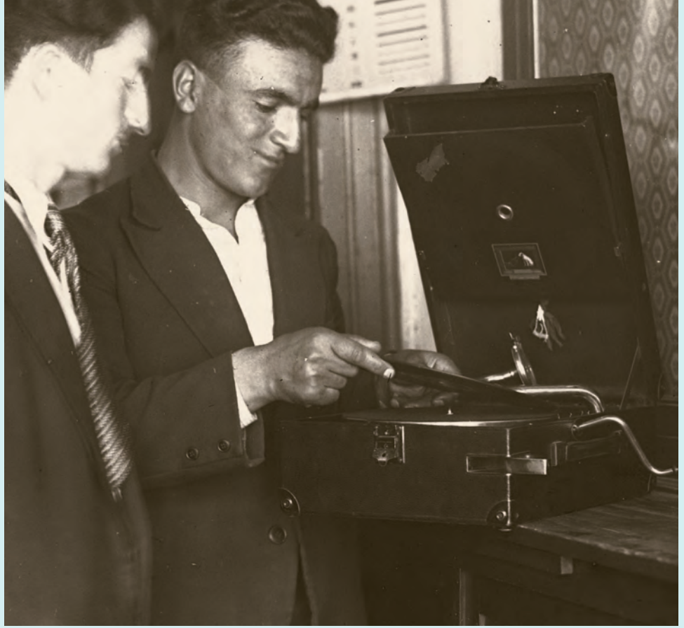
2- Pikaba plak yerleştirilmesi (İBB, Kültür A.Ş.)
