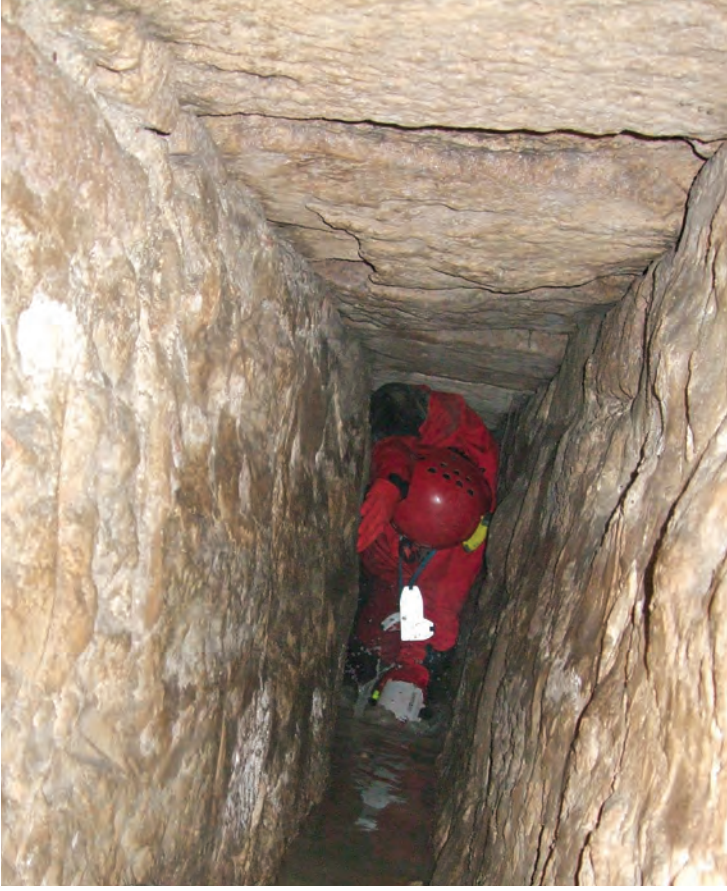
11a- Geç Roma dönemi su kanalının en dar yeri
