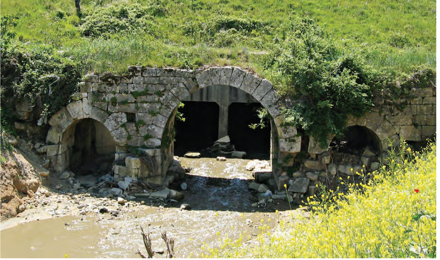
4- Başakşehir ilçesinde TEM Otoyolu kenarında yer alan Roma köprüsü
