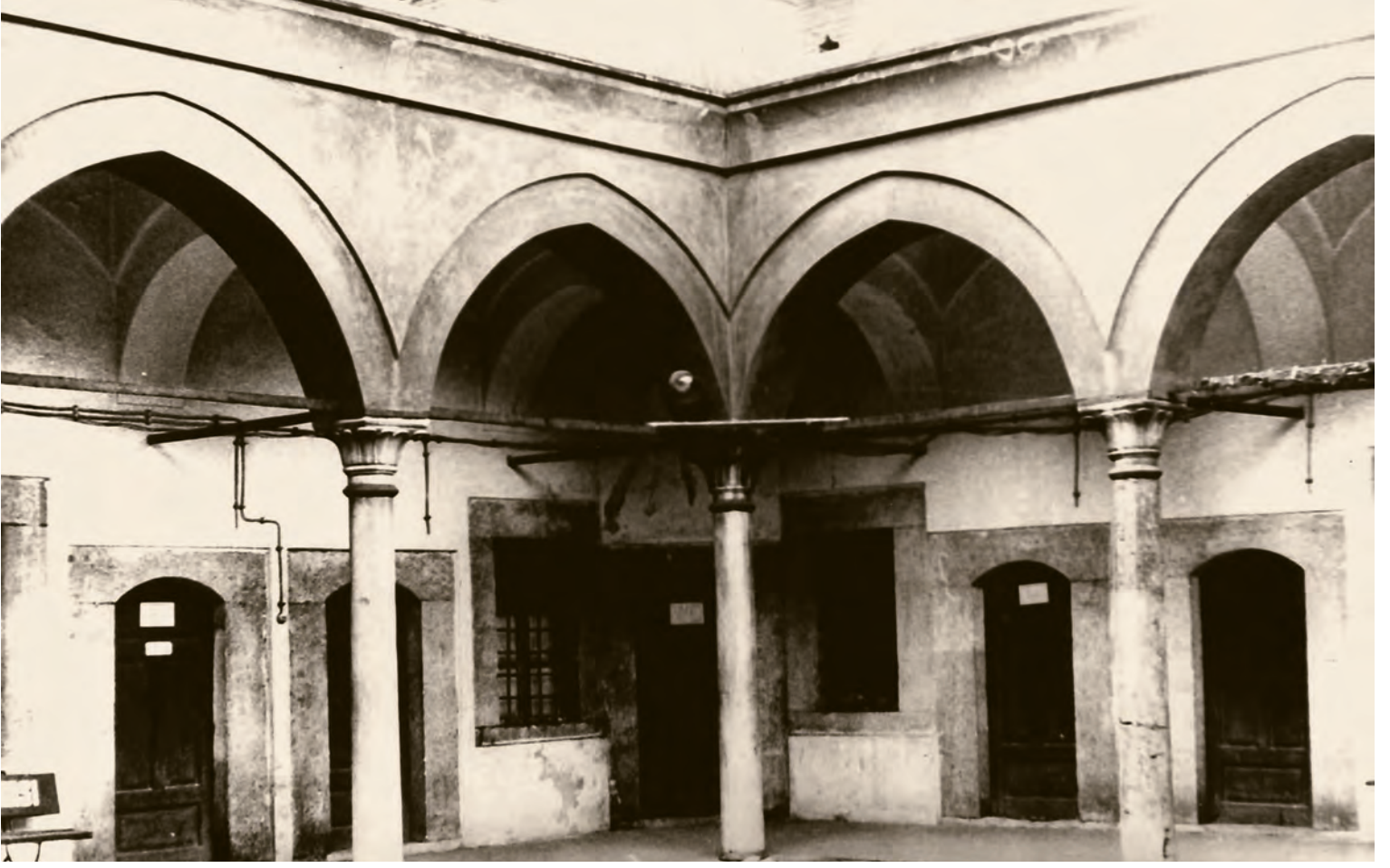
8- Hacı Beşir Ağa Tekkesi - avlu revaklarının kuzeybatı köşesi (İÜ, Sanat Tarihi Bölümü Arşivi, 1974)
