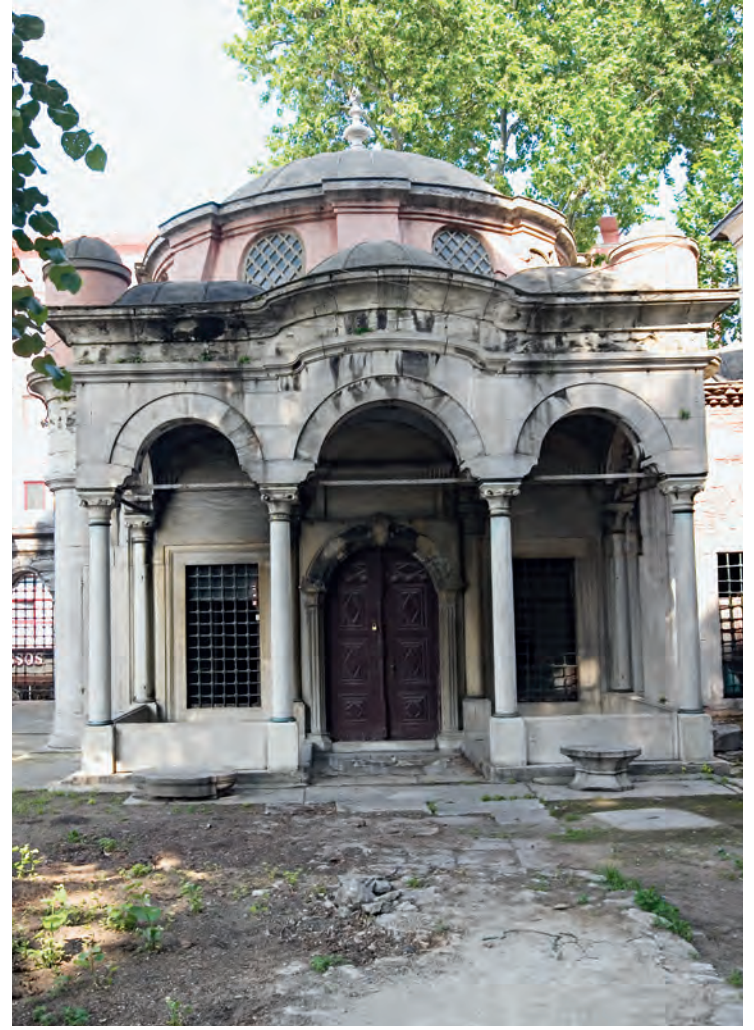
17- Şehsuvar Valide Sultan Türbesi
