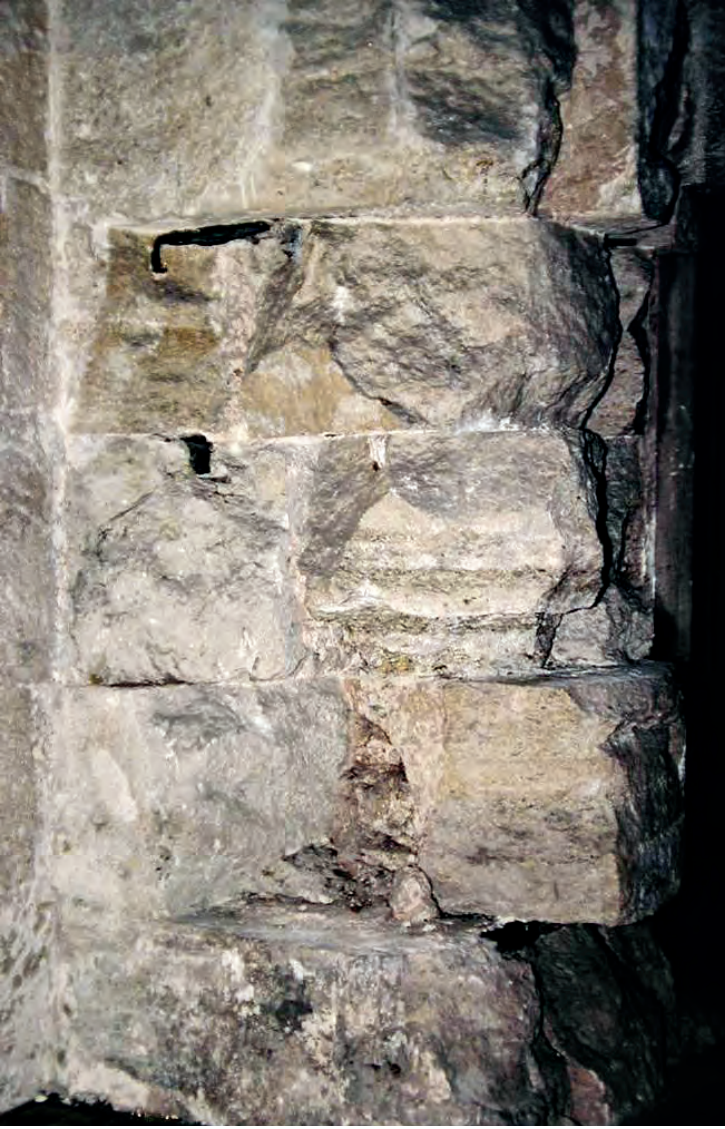
10a- Cerrahpaşa Kenetli Örgü
