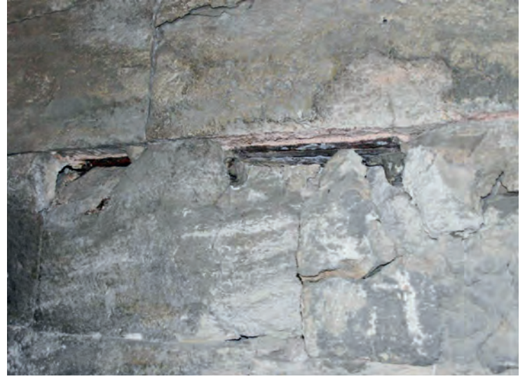
10b- Cerrahpaşa Kenetli Örgü
