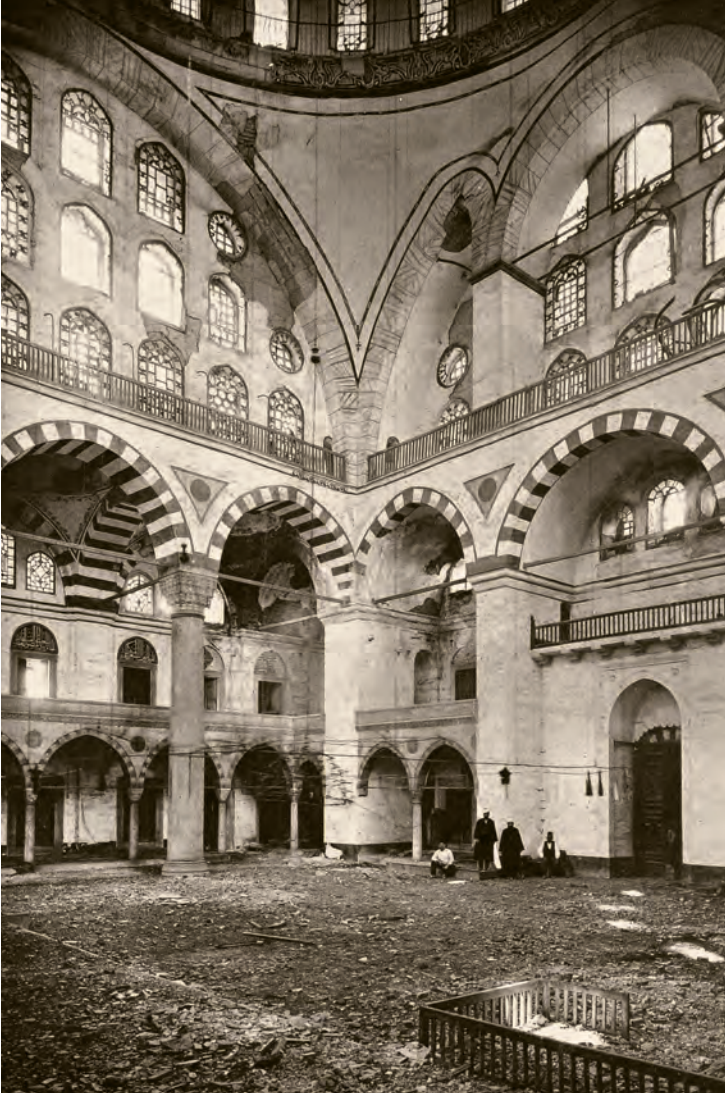
15- Bir deprem sonrası Edirnekapı'daki Mihrimah Sultan Camii'nin içi (Gurlitt)
