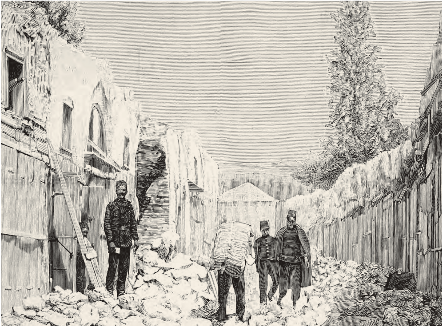
4- Bir deprem sonrası harabeye dönen şehir
