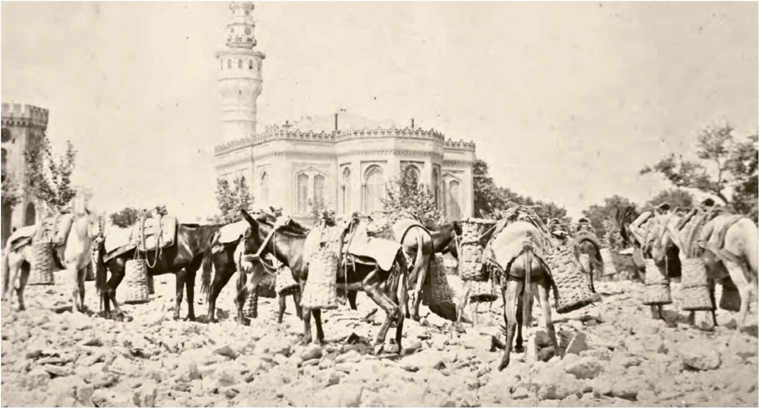
12- 1894 depreminde Harbiye Nezareti önünde enkaz kaldırma çalışmaları (İBB Atatürk Kitaplığı, Albüm nr. 184)
