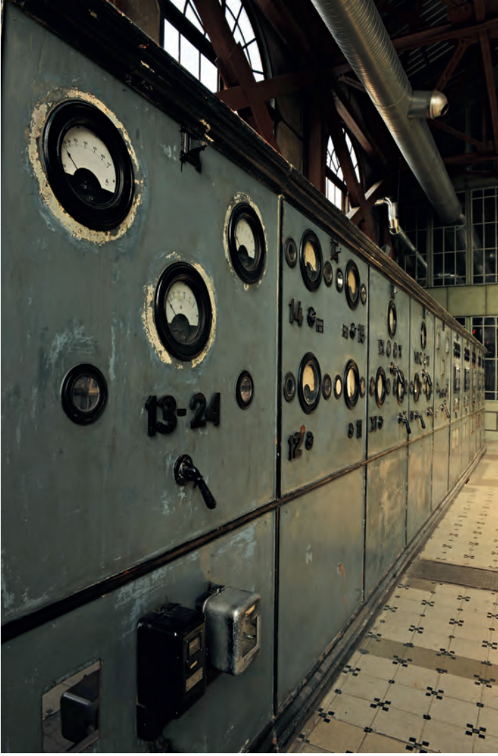
16- Silahtarağa Elektrik Fabrikası'nın transformatörleri
