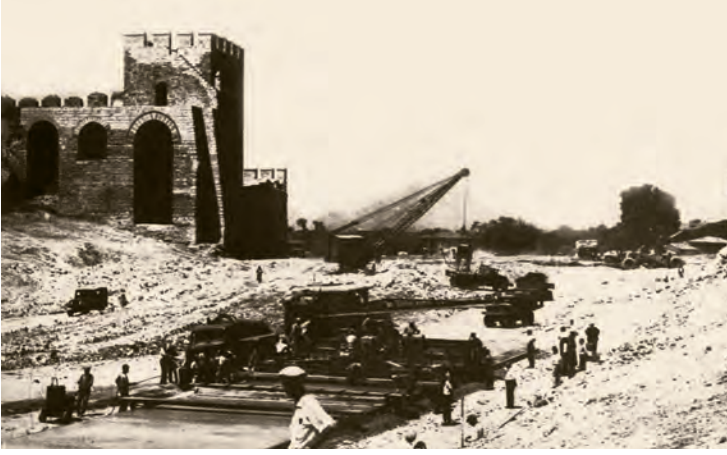
3- "Edirne-İstanbul devlet yolunun İstanbul'a giriş kapısı ve aynı zamanda 50 metre genişliğindeki Millet Caddesi'nin başlangıç noktası olan Topkapı surları bölümünde restore edilen burçlar. Avrupa'dan İstanbul'a giriş yapan her yolcuya muhteşem tarihi şehirlerimizin en müessir intibalarını verebilecek hüviyettir. Resmimiz, Millet Caddesi başlangıcında beton makinesini 25 santim kalınlığında beton dökerken gösteriyor"
