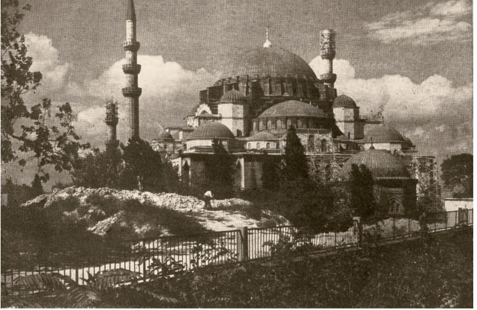
2- Fatih Camii. Sağ minaresinin külâhı yıkılmış. Demokrat Parti döneminde restore edilen tarihî yapılardandır (İstanbul'un Kitabı)
