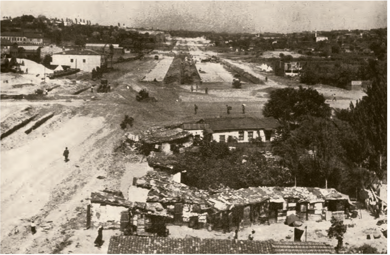
12- Bayrampaşa vadisinden başlayarak Murat Paşa Camii ile Valide Camii arasından Aksaray Meydanı'na inen Vatan Caddesi'nin bölgede yıkımlar yapıldıktan sonraki görünüşü (İstanbul'un Kitabı)
