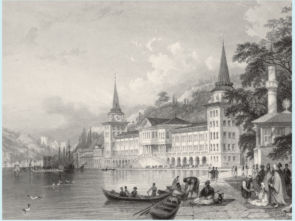
1- Kuleli Askerî Lisesi (Allom)
